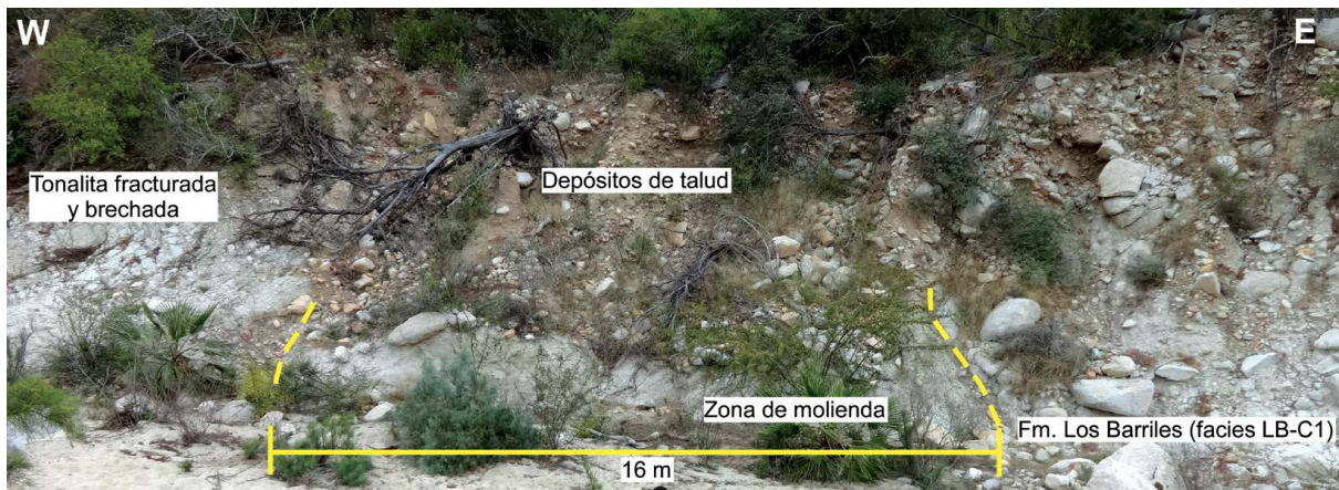
Figura 4. Sistema de fallas Los Barriles, segmento C (Figura 3: localidad 14). En esta localidad la zona de molinda mide 16 m de ancho.
